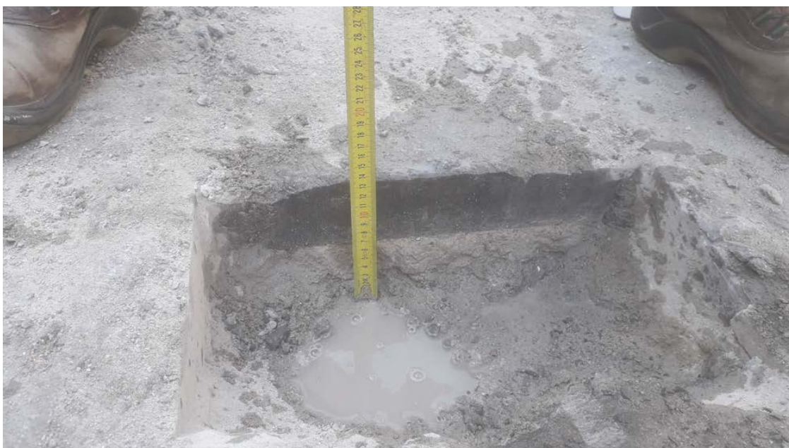
Vista del morter de nivelació i del morter de base de les peces existents de pedra natural de Sant Vicenç, de 7 cm de gruix, que es renovaran.
