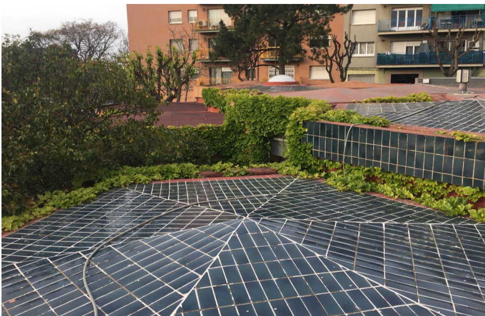
Coberta façana est.
