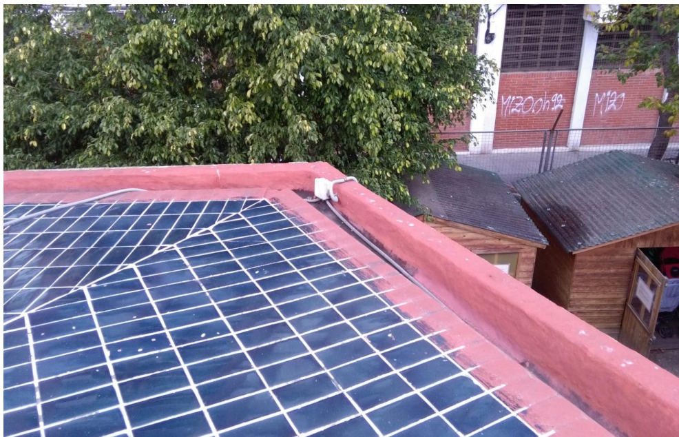
Caixes de derivació fixades a canals
