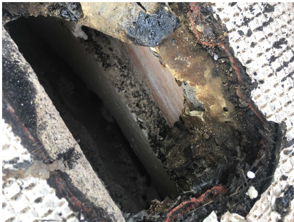
Cala prospecció junta estructural
