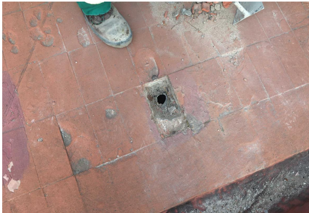
Cala prospecció envanets de sostre mort al mig dels hexàgons
