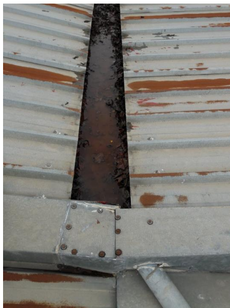
Canals Ocults i sobreixidor
