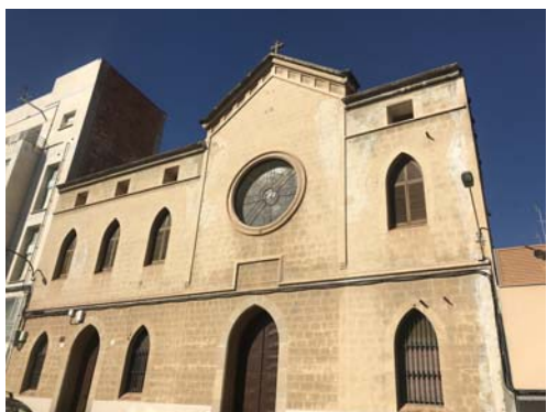
FAÇANA ESSLÈSIA SERVANTES DE MARIA
