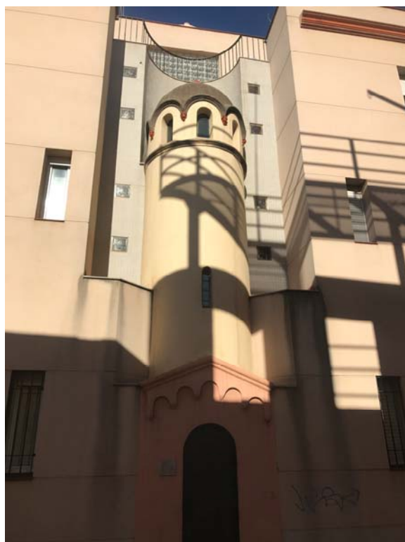
TORRE REPARTIDOR D'AIGÜES
