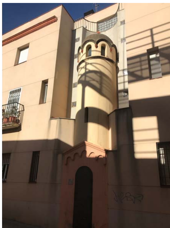
TORRE REPARTIDOR D'AIGÜES
