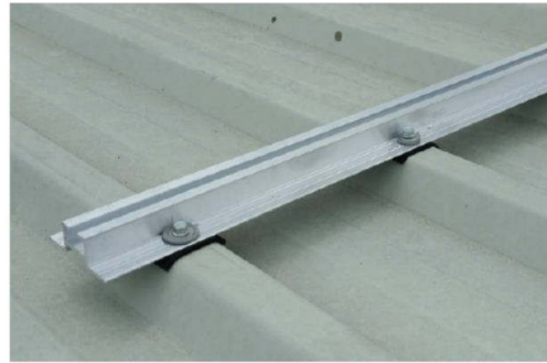
fig. 1 Subjecció estructura a coberta
