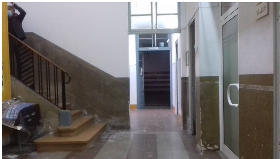
Vista interior vestibul edifici Núm. 1
