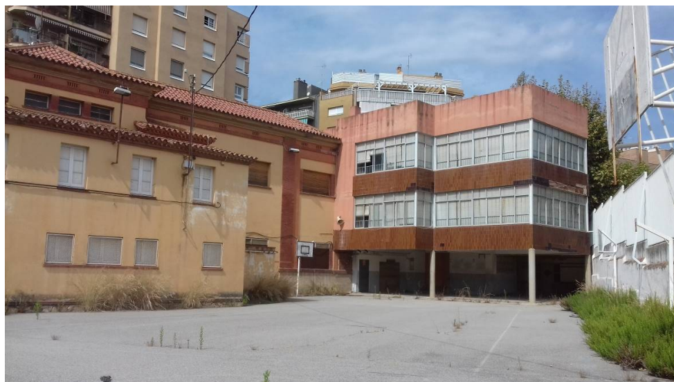
Vista façanes posteriors edificis des del pati
