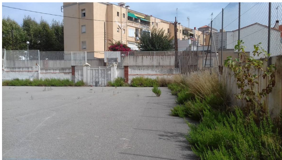
Murs exteriors no objecte d'enderroc
