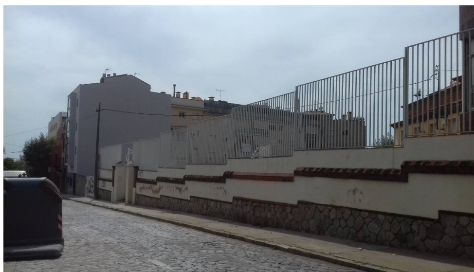
Vista mur tancament Carrer de Alarcón no objecte d'enderroc
