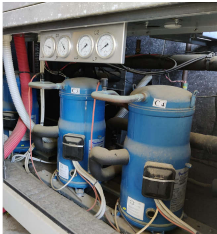
Imatge 1 Planta refredadora existent
