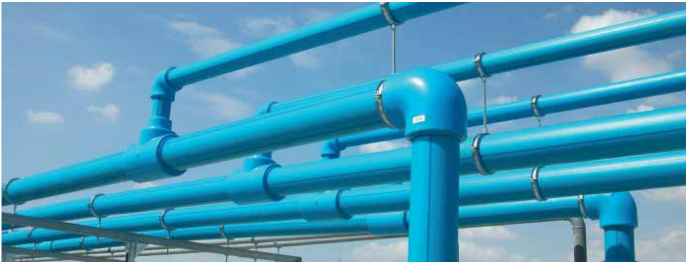
Fotografía realizada previamente a la colocación de aislamiento.
