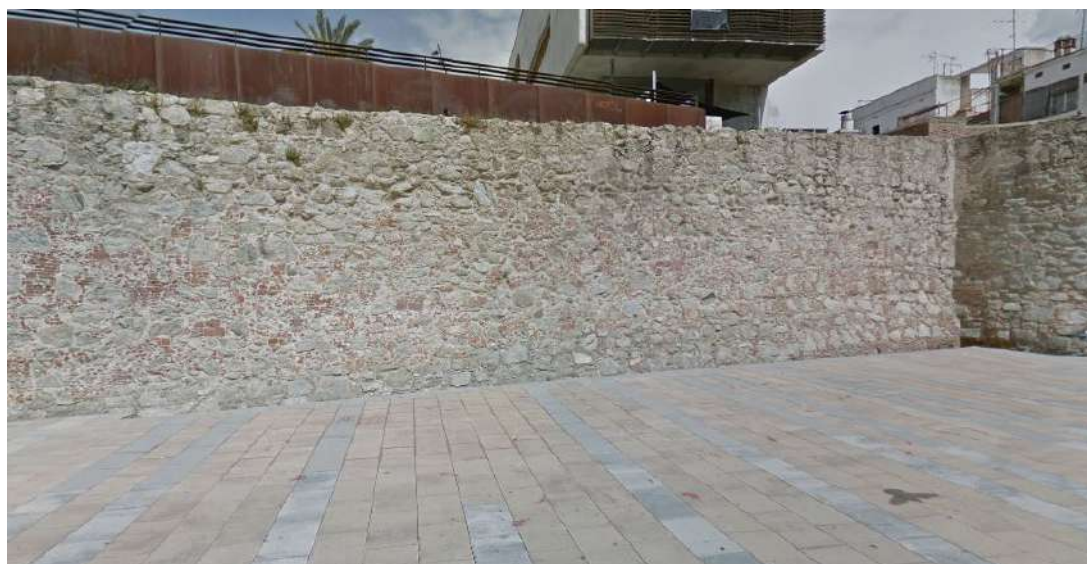
Exterior esglaonat mur.
