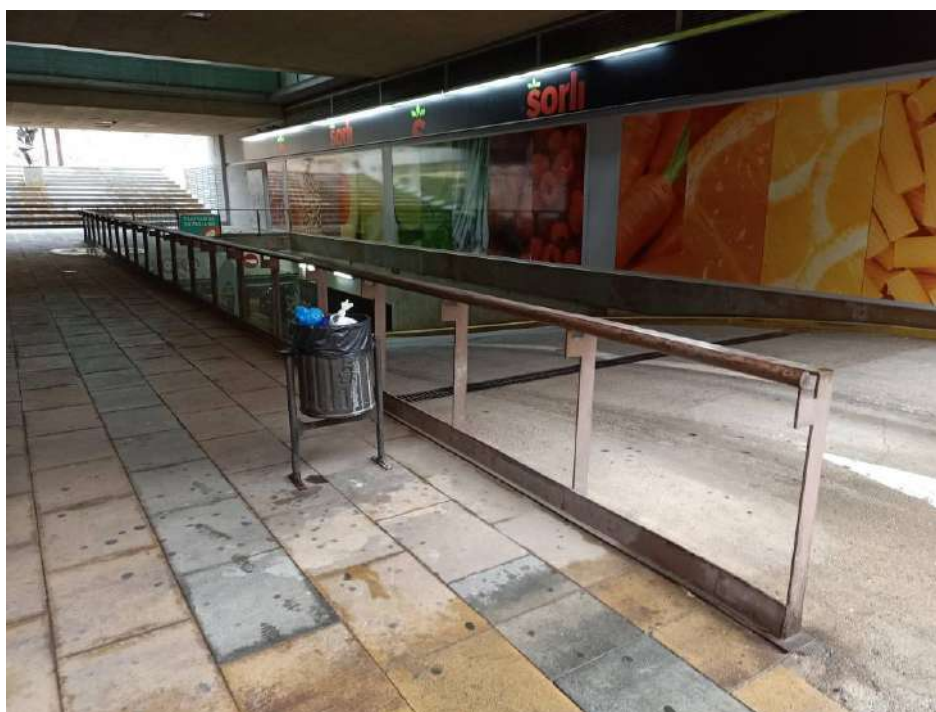
Galeria interior barana de seguretat.
