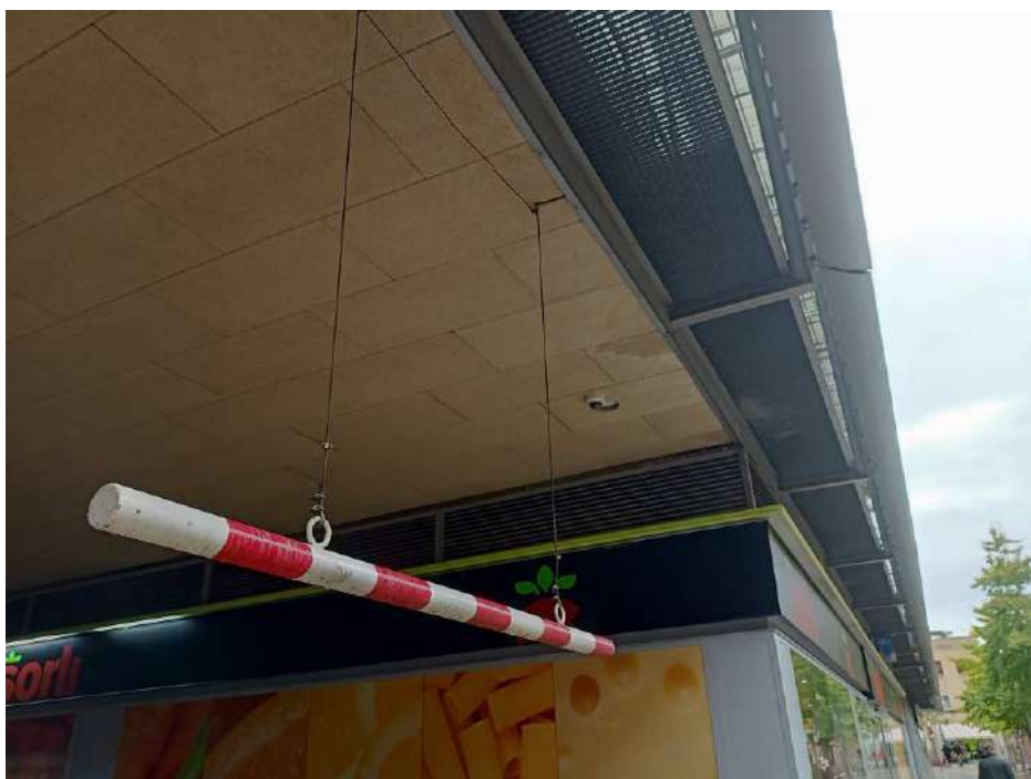
Galeria interior accés aparcament instal·lacions existents.
