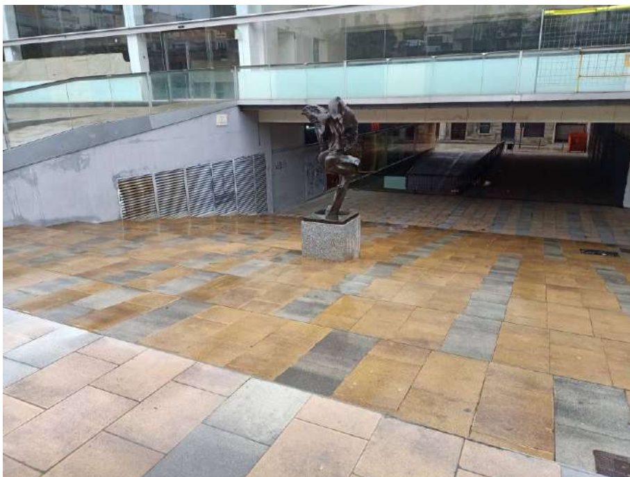
Vista accés galeria plaça de la Muralla.
