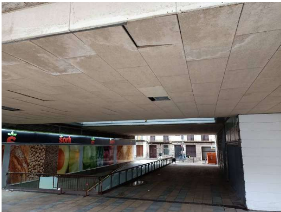
Vista de galeria interior accés aparcament.
