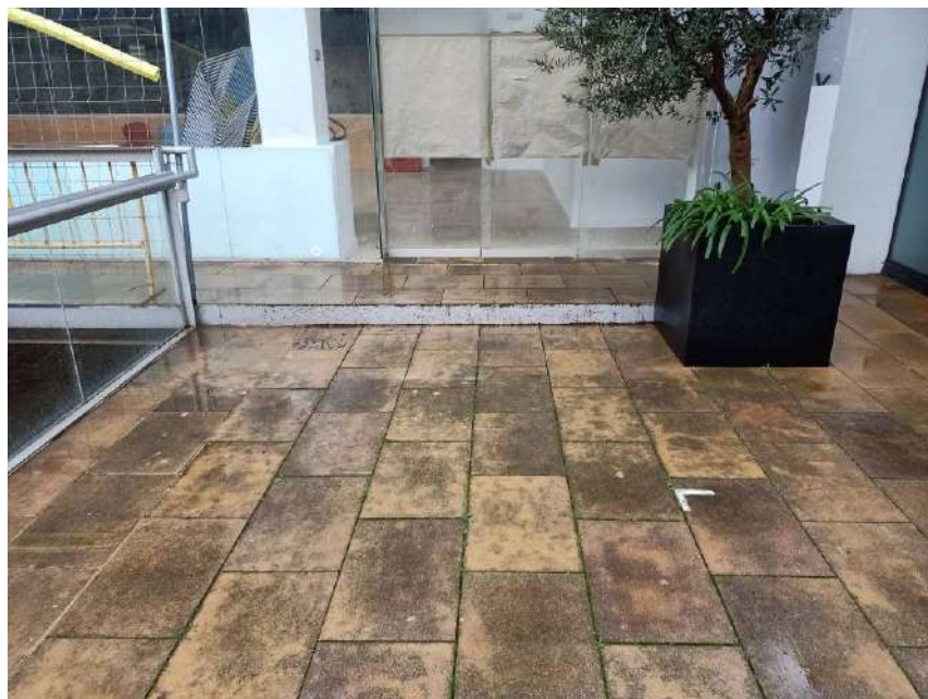
Exterior accés lateral escales.
