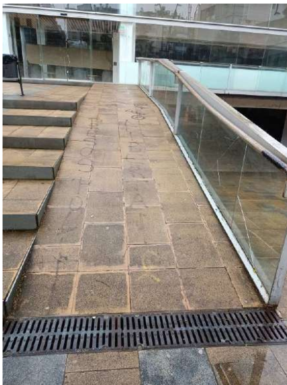
Exterior rampa accés existent.
