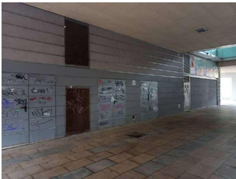
Galeria interior façana edifici.
