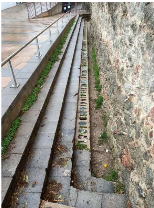
Exterior esglaonat mur.
