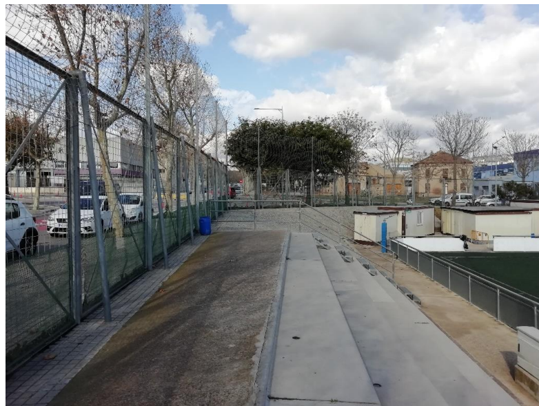
Zona grades amb nova sortida d'evacuació
