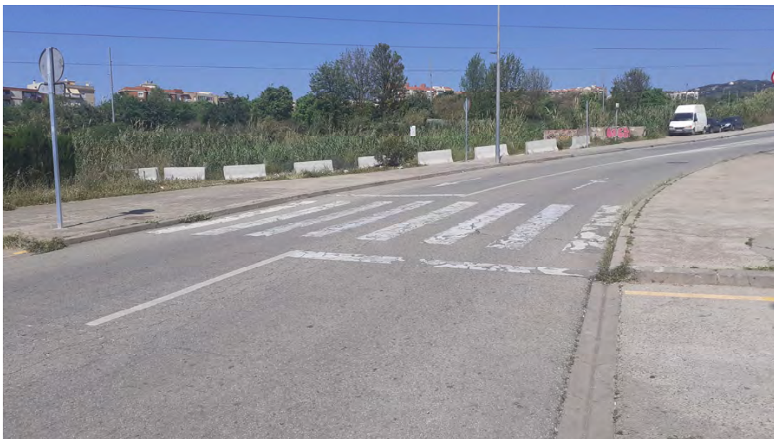
Vista de calçada a realitzar reforç del ferm i pas de vianants a adaptar al carrer de l'Energia.
