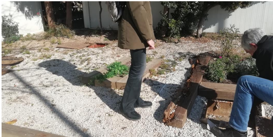
Dipòsit soterrat de reg
